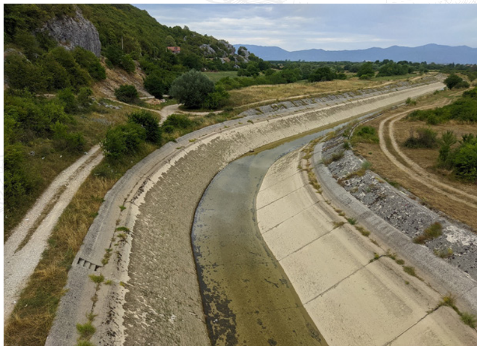
Slika 5. Kanalisani dio gornjeg toka rijeke Zete za hidroenergetske potrebe
